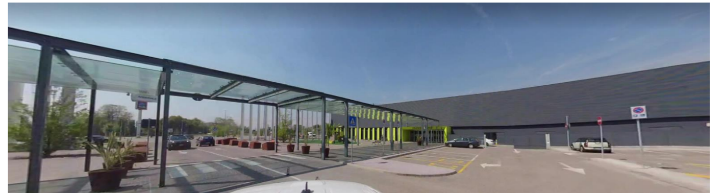
Vista dal parcheggio centrale all'ingresso ovest
