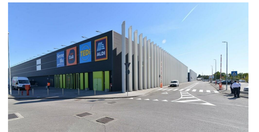
Vista angolo nord-ovest
