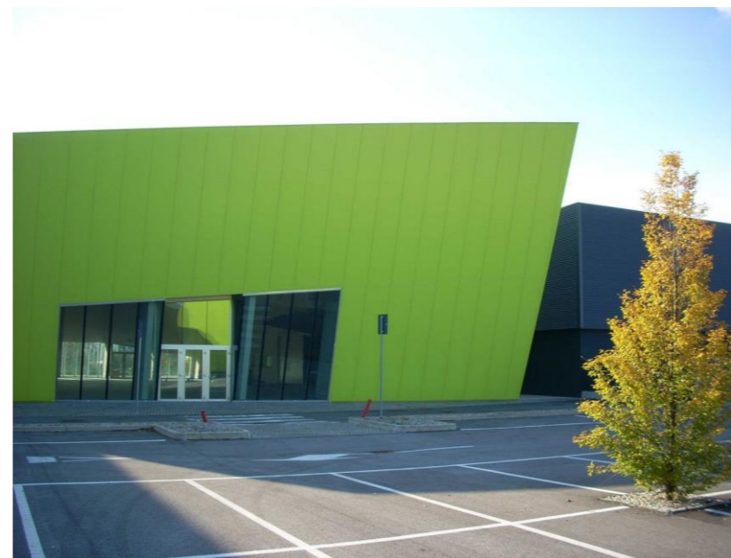
Accesso dal parcheggio centrale al centro commerciale
